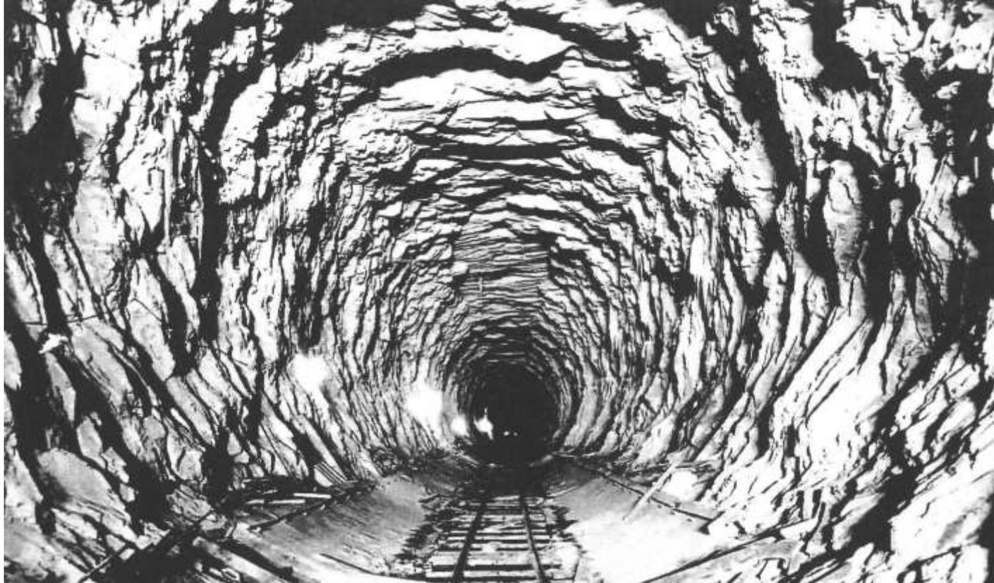
L' Hawks Nest Tunnel (West Virginia) è una derivazione d'acqua lunga 4,8 km con diametro di 9,1 m, dal torrente allo stabilimento della Union Carbide per produrre energia elettrica: è ancora attivo.
