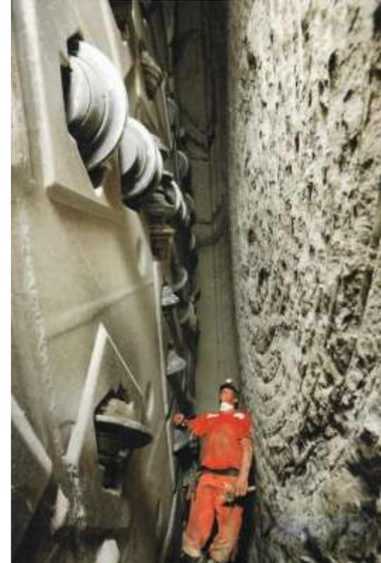
La testa rotante per l'abbattimento della roccia di una TBM (Tunnel Boring Machine – Macchina di scavo integrale, cioè a piena sezione, di una galleria) che sta lavorando in buona roccia coerente
