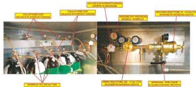
5. aprire le valvole di intercettazione delle bombole e del collettore per mettere in pressione il gruppo di riduzione.
